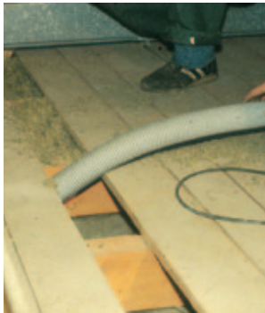
Dämmung einer Holzbalkendecke mit Rockwool Granulat
