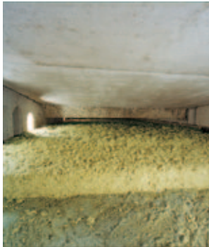
Belüftetes Flachdach mit Rockwool Granulat gedämmt
