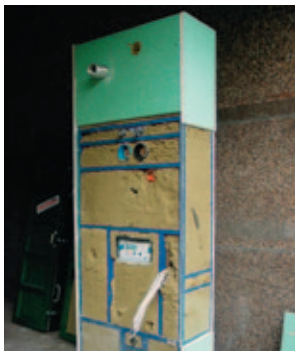
Schacht mit Firesafe-Granulat ausgeblasen
