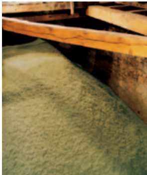
Abrutschsicher aufgebaute Dämmschicht
