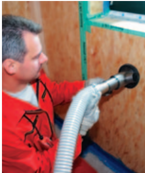
Ausblasen eines Außenwand-gefaches
