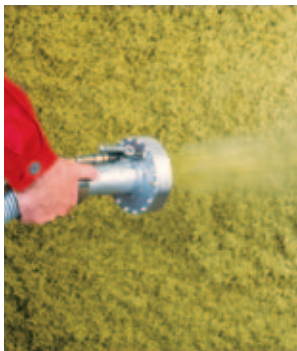
Benetzen der Steinwolle-Flocken mit Sprühkleber
